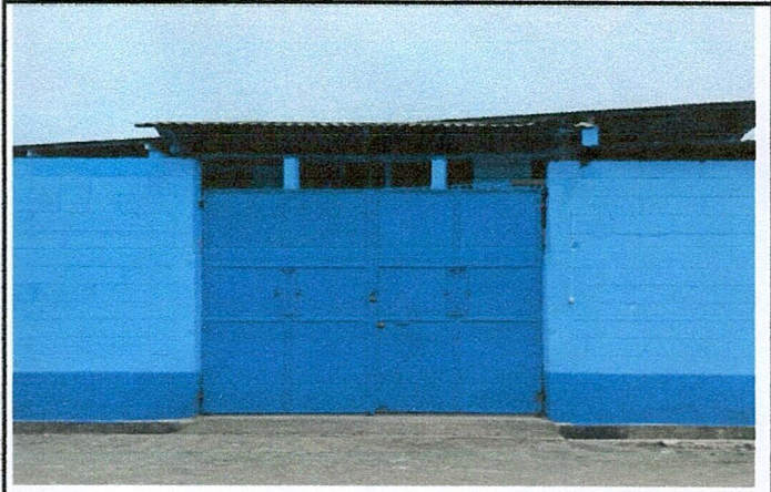
Foto 4: Colocación del portón nuevo del establecimiento.
