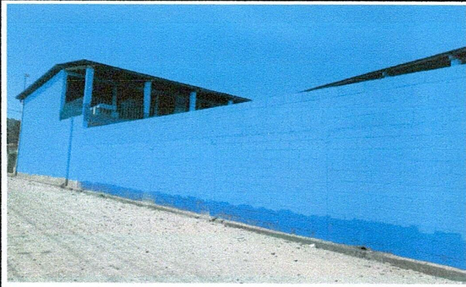
Foto 1: Finalización de la colocación de block.
