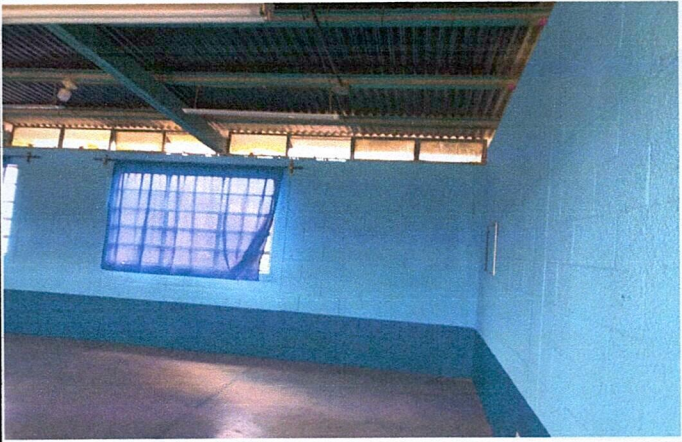
Foto 4: Aulas terminadas de pintar.
