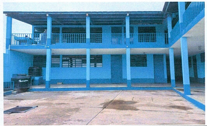
Foto 2: Pintura de las instalaciones de los dos niveles del establecimiento.
