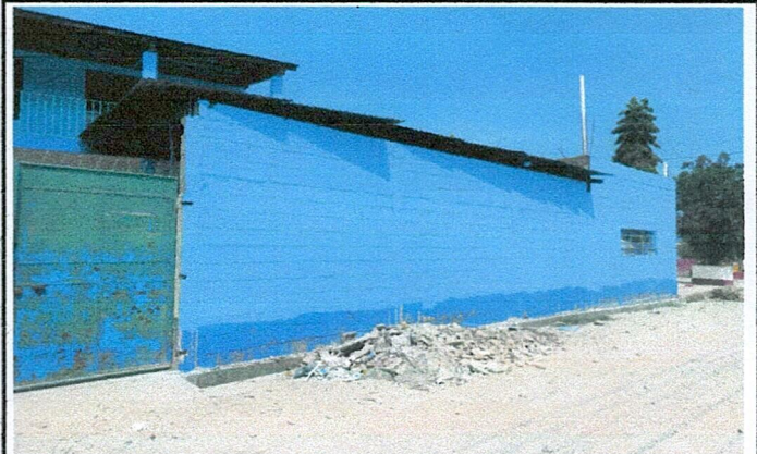
Foto 2: Finalización de la colocación de block del muro.
